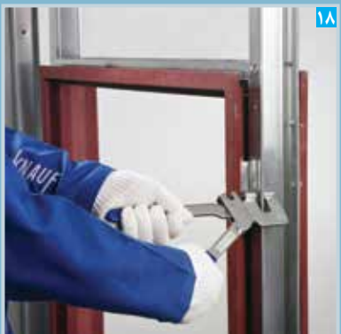
۱۸ اتصال رانر نعل درگاه به استاداها با پانچ
