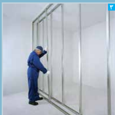
اجرای ردیف دوم استاداها
