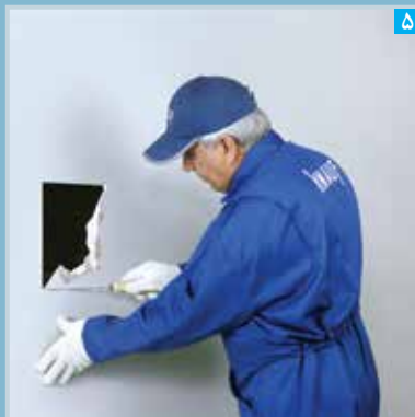
برش محل آسیب دیده به شکل قطعه ترمیمی
