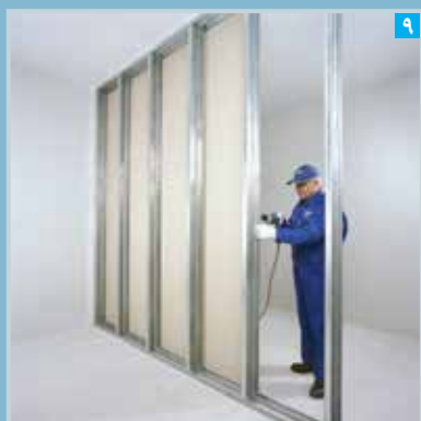
اجرای پنل ها در یک طرف دیوار
