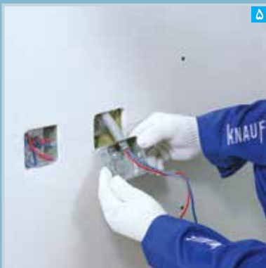
خروجی های تاسیساتی به وسیله اره چاقویی و سوهان ایجاد می شود (در نصب قوطی های برق فلزی با سازه پشتیبان، برش کاری خروجی قبل از نصب پنل صورت می گیرد)
