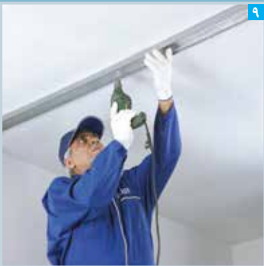
نصب رانر سقف (سوراخ کردن رانر و سقف)
