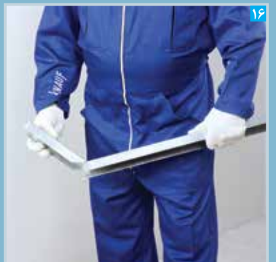
۱۶ خم کردن انتهای رانر نعل درگاه
