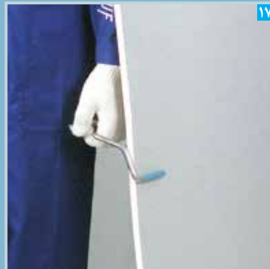
حمل پنل به سادگی با گیره مخصوص و توسط دو نفر انجام می شود
