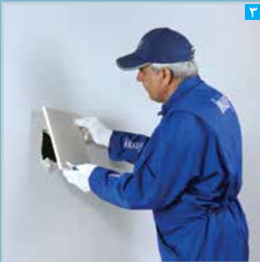
قرار دادن قطعه ترمیمی بر روی محل آسیب دیده
