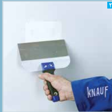
۲ اجرای بتونه بر روی وصله ترمیمی
