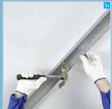
اتصال رانر به سقف با رول پلاگ
