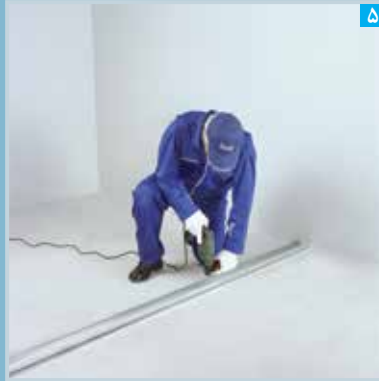
نصب رانر کف (سوراخ کردن رانر و کف)
