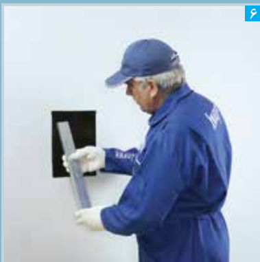
قرار دادن قطعه پروفیل در درون دیوار به منظور ایجاد زیرسازی در محل آسیب دیده
