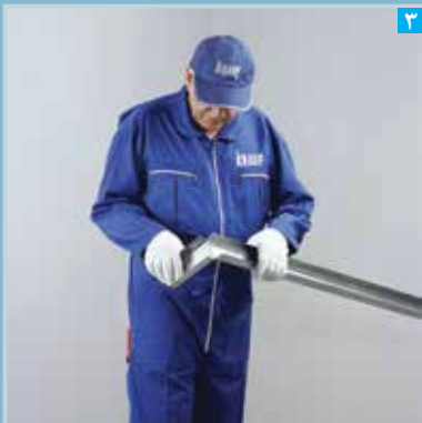
پس از برش بال‌ها، رانر خم و راست شده تا از محل جان برش بخورد
