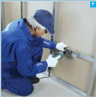
اتصال قوطی برق به سازه پشتیبان
