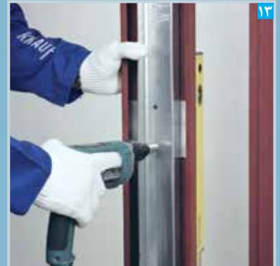
۱۳ چهارچوب توسط پیچ LB در محل صفحات نصب به استادا متصل می شود
