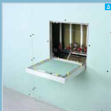
دریچه نصب شده
