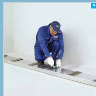
برش نوارهای عایق
