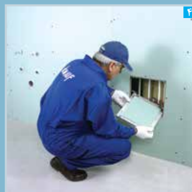
قرار دادن پتل دریچه در درون قاب
