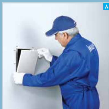
۸ قرار دادن قطعه پنل جایگزین در محل خود
