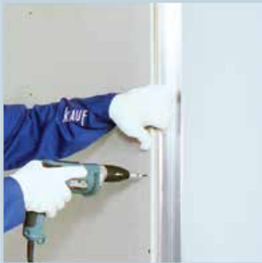
پنل باید در جهتی نصب شود که لبه آزاد آن به سمت دهانه باز استاد قرار گیرد
