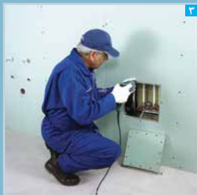
اتصال قاب دریچه
