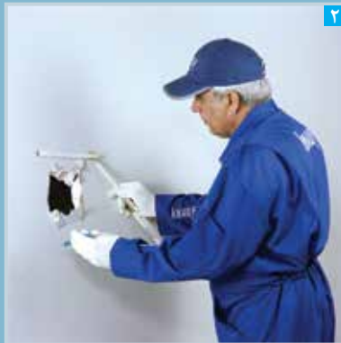
اندازه گیری محل آسیب دیده جهت تهیه قطعه پنل جایگزین
