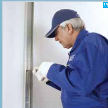
اتصال استاد به دیوار بتایی با رول پلاک
