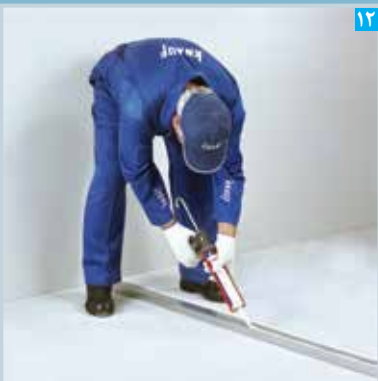
اجرای دو ردیف خمیر سیلیکون (یا نوار عایق) بر پشت جان استادهای جانبی
