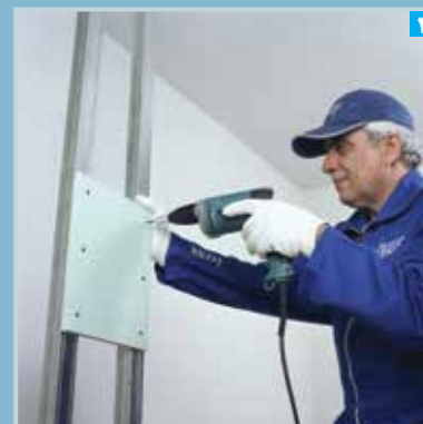
استادهای ردیف اول و دوم به وسیله برش هایی از پنل به یکدیگر متصل می شوند
