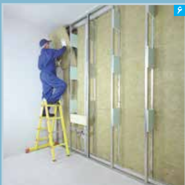
اجرای عایق پشم معدنی (پس از اجرای تاسیسات)
