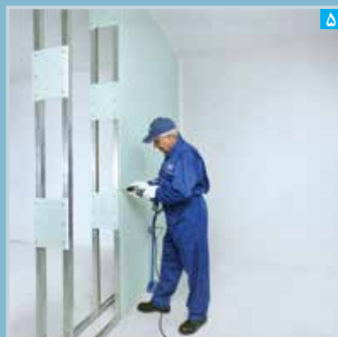
اجرای پنل ها در یک طرف دیوار
