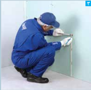
تعیین محل خروجی های تاسیساتی
