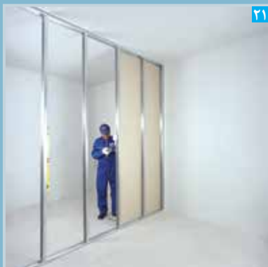
اجرای پنل ها در یک طرف دیوار
