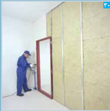
۳۰ پیچ زنی پنل در حاشیه دور چهارچوب
