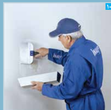
۱۰ بتونه کاری درزها در محل ترمیم (با استفاده از نوار و بتونه درزگیر کناف)
