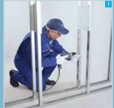
اتصال قطعات نبشی L25 به استادهای مجاور
