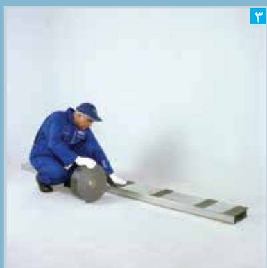
اجرای نوار عایق بر روی استادهای
