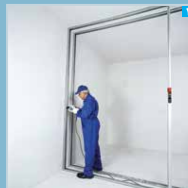
دو ردیف قاب با فاصله از یکدیگر اجرا می شوند (فاصله قاب ها به حجم تاسیسات بستگی دارد)
