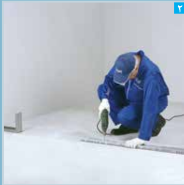
۲ نصب رانر کف
