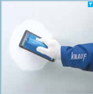
۳ پرداخت سطح بتونه کاری شده و آماده سازی جهت پذیرش پوشش نهایی
