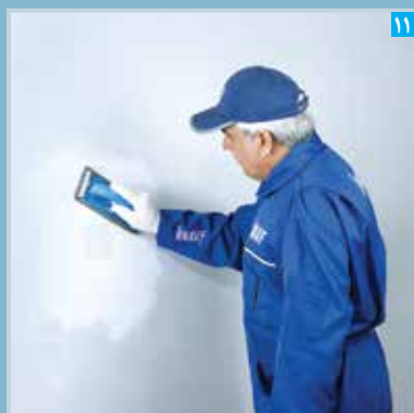
۱۱ پرداخت سطح بتونه کاری شده و آماده سازی جهت پذیرش پوشش نهایی
