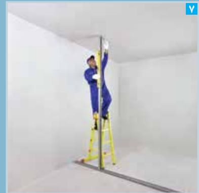
انتقال تصویر رانر کف به سقف (با استفاده از استاد و تراز)
