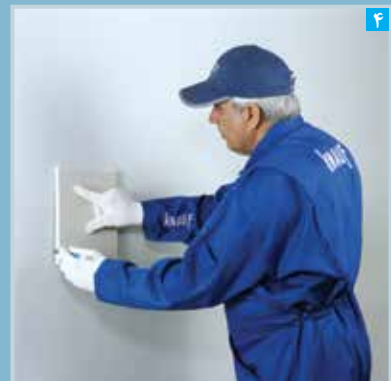
علامت گذاری محل استقرار قطعه ترمیمی بر روی دیوار
