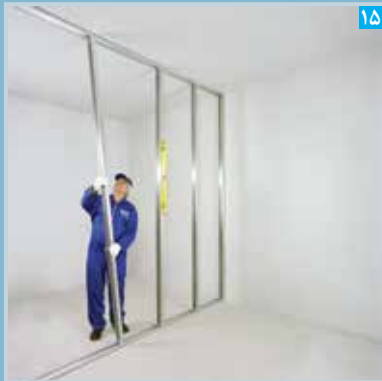
اجرای استاداها (به صورت شاقولی)
