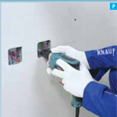
قوطی برق می تواند پس از نصب پنل، به سازه پشتیبان متصل شود
