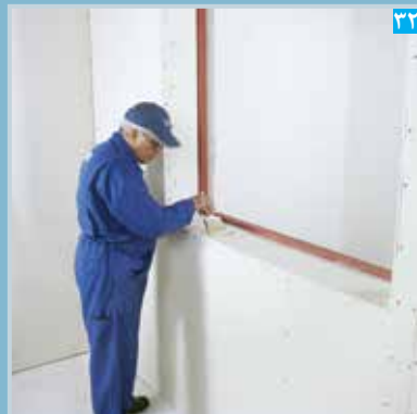
اجرای پرایمر بر روی سطح پنل
