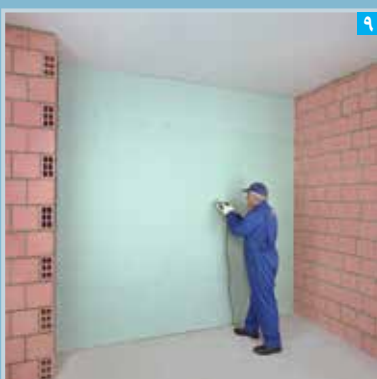
نصب لایه دوم پنل ها و تکمیل ساختار
