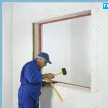
۲۶ تنظیم پنل نواری (گونیا کردن)
