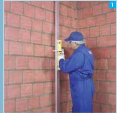
اندازه گیری میزان ناهمواری دیوار
