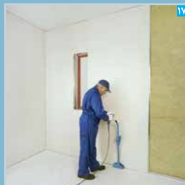
۱۷ نصب پنل بر روی زیرسازی
