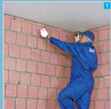
۱ مشخص کردن محل نصب رانر سقف با ریسمان رنگی
