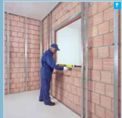
۴ تنظیم سازه قاب بندی به وسیله تراز
