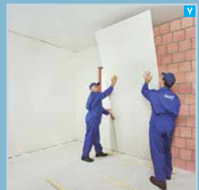
استقرار پنل بر روی دیوار زمینه
