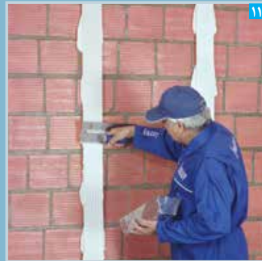
اجرای لایه فوگن فولر بر روی کرم ها با استفاده از ماله دندانه دار
