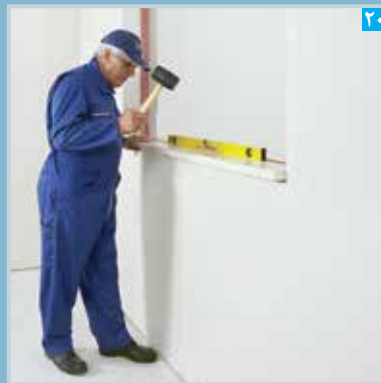
۲۰ نصب و تنظیم سنگ کف پنجره
