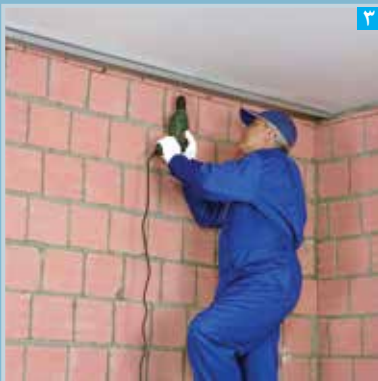
۳ نصب رانر سقف
