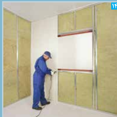
۱۴ نصب پنل بر روی زیرسازی
