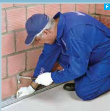
۶ نصب رانر کف
