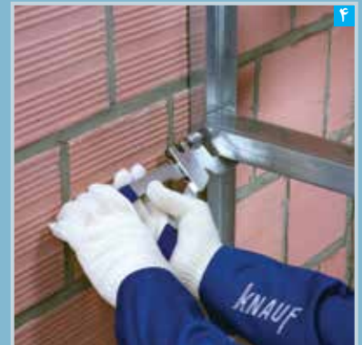
اتصل و تثبیت استاد به رانر (به وسیله بانچ، پرچ یا پیچ)
