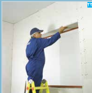
۲۳ تنظیم لبه های پنل در محل کنج
