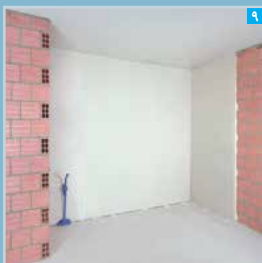
پوشش کاری تکمیل شده
