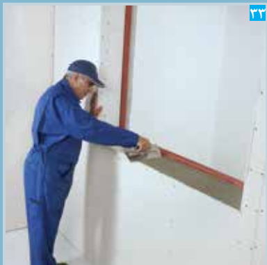
اجرای چسب کاشی بر روی سطح پرایمر خورده
