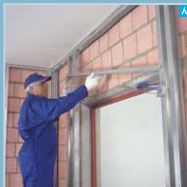
۸ استقرار رانر قاب بندی فوقانی (به جهت خم ها توجه شود)
