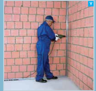
نصب اولین استاد بر روی ساختار جانبی
