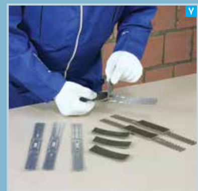
۷ نصب قطعات فوم (عایق) بر پشت براکت ها
