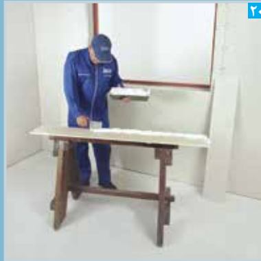
۲۰ اجرای پرلفیكس بر پشت پنل نواری (برای پوشش کاری ناحیه داخلی دور بازشوی پنجره)
