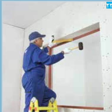
۲۳ تنظیم پنل نواری (گونیا کردن)
