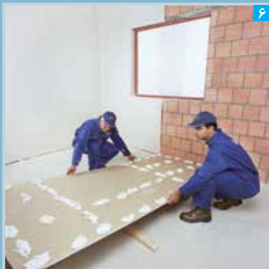
به نحوه اجرای پرلنیکس در محل بازشوی پنجره توجه شود
