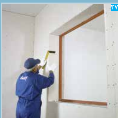
۲۷ تنظیم پنل نواری (گونیا کردن)
