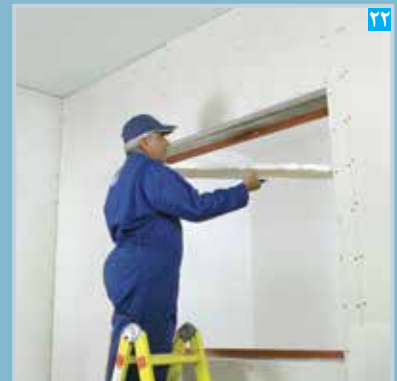
۲۲ استقرار پنل نواری در ناحیه داخلی دور بازشوی پنجره
