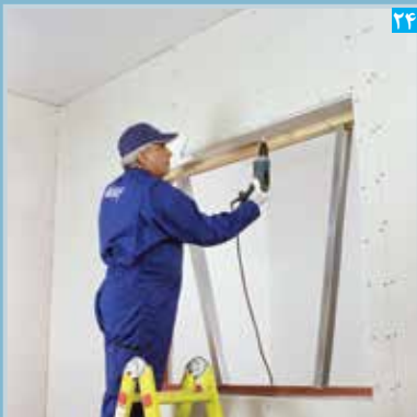
۲۴ اتصال پنل نواری به رانر قاب بندی فوقانی
