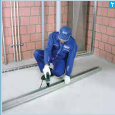
۳ اجرای استادهای دوتایی
