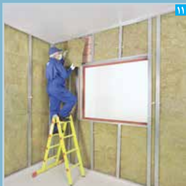
۱۱ اجرای عایق پشم معدنی
