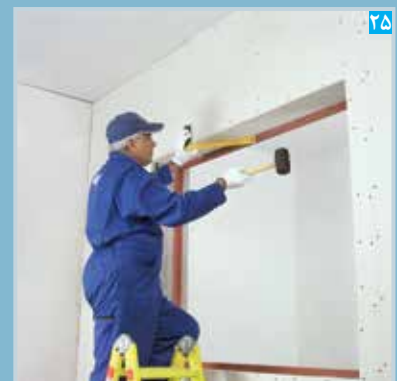
۲۵ تنظیم پنل نواری (گونیا کردن)
