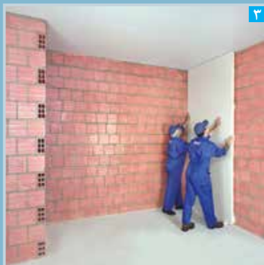
استقرار پنل بر روی دیوار زمینه
