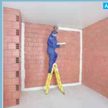
اجرای پرلنیکس به صورت نوار پیوسته در حاشیه پیرامونی دیوار زمینه
