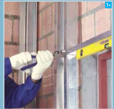
۱۰ اتصال راتر قاب بندی فوقانی به استاد به وسیله پانچ، پرچ یا پیچ (به جهت برش ۴۵ درجه توجه شود)
