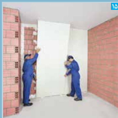
پنل ها بر روی محور مرکزی ردیف های پرفیکس مستقر می شوند
