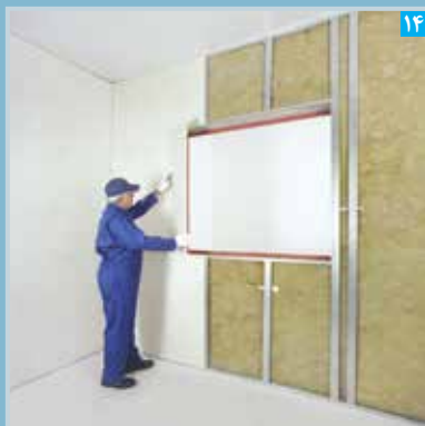
۱۴ برش پنل با استفاده از تیغ برش
