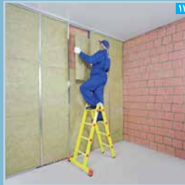
اجرای عایق پشم معدنی (توجه: در فاصله میان استاداها)
