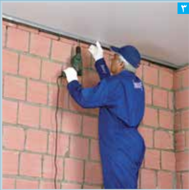
۳ نصب سازه هادی سقف
