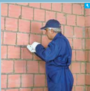
۹ نصب براکت بر روی دیوار زمینه
