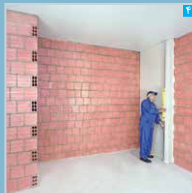
بررسی تراز و تنظیم بودن پنل نصب شده با استفاده از شمشه و تراز
