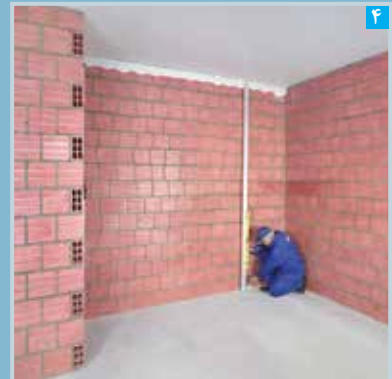
مشخص کردن محل نصب کرم پایین با استفاده از شمشه و تراز
