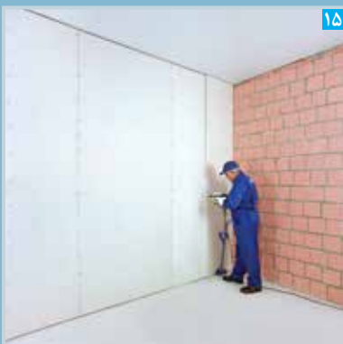
اجرای لایه دوم پنل ها؛ ساختار W626 (لایه دوم نسبت به لایه اول به صورت خمیرچین اجرا می شود)
