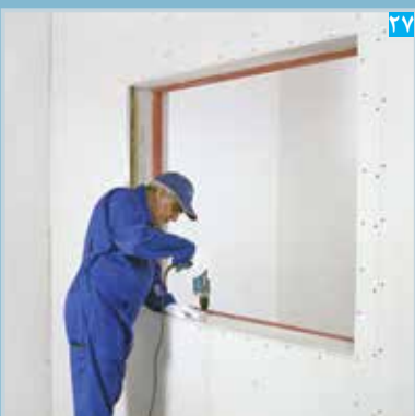
۲۷ اتصال پنل نواری به سازه قاب بندی تحتانی
