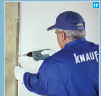
توجه: پنل ها باید در جهتی نصب شوند که لبه آزاد آن ها به سمت دهانه باز استاداها قرار گیرد
