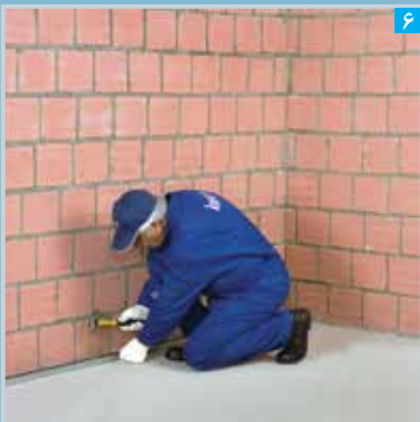
۶ نصب سازه هادی کف
