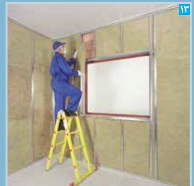
۱۳ اجرای عایق پشم معدنی
