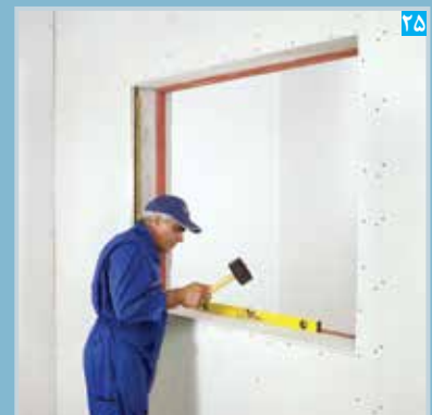
۲۵ تنظیم پنل نواری (تراز کردن)
