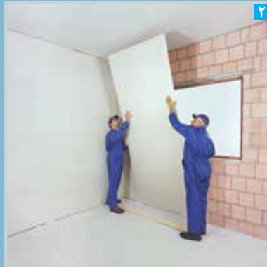
استقرار پنل بر روی دیوار زمینه
