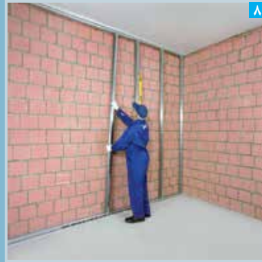
اجرای استاداها (به صورت شاقولی)
