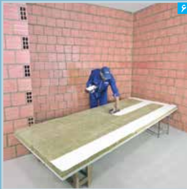
اجرای لایه نواری پرلنیکس بر روی لایه پشم معدنی (پشت صفحه مرکب MW)
