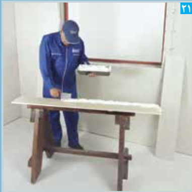
۲۱ اجرای پرل‌فیکس بر پشت پنل نواری (به اجرای یکپارچه پرل‌فیکس توجه شود)
