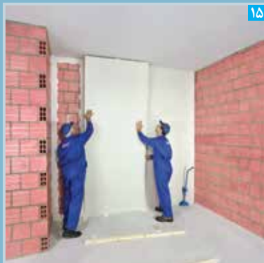
پنل ها بر روی محور مرکزی کرم ها مستقر می شوند
