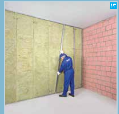
۱۳ استقرار سازه های قائم در سازه های هادی و میان برکت ها
