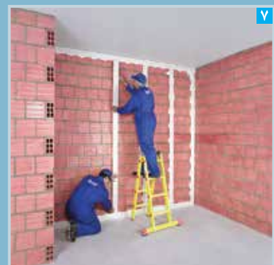
نصب کرم ها به فاصله حداکثر ۶۰ سانتیمتر از یکدیگر (مرکز به مرکز)
