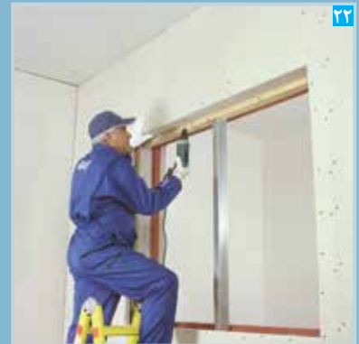
۲۲ اتصال پنل نواری به سازه قاب بندی فوقانی
