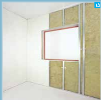
۱۵ در محل بازشوی پنجره، برش پنل به صورت 'C' شکل صورت می گیرد
