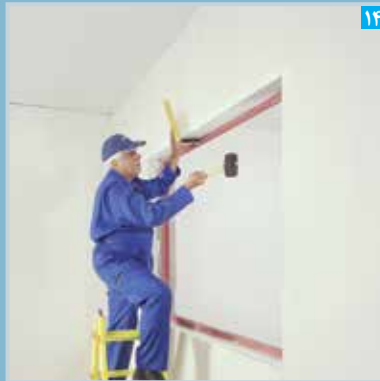
نصب و تنظیم پنل نواری
