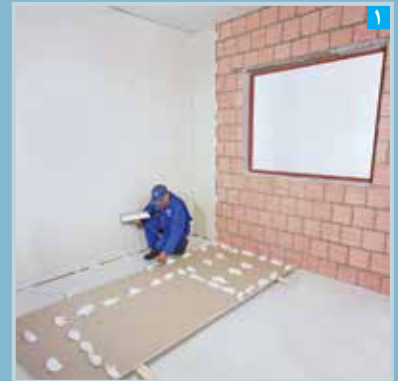
اجرای چانه های پرلنیکس بر پشت پنل
