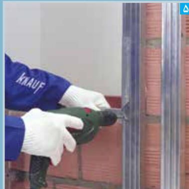
۵ اتصال سازه قاب بندی به سازه قائم به وسیله پرچ یا پیچ (به جهت برش ۴۵ درجه توجه شود)
