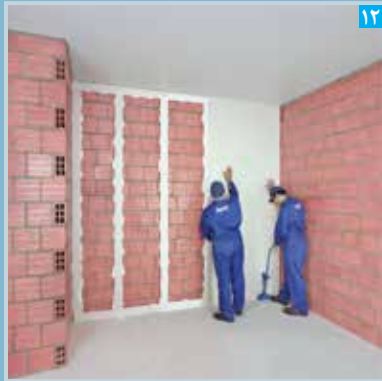
نصب پنل با استفاده از جک نگهدارنده
