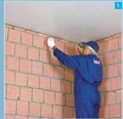
۱ مشخص کردن محل نصب سازه هادی سقف باریسمان رنگی
