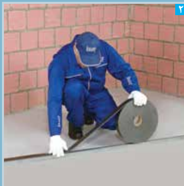
۲ اجرای نوار عایق (با دو ردیف خمیر درزبند) بر پشت جان رانر کف و سقف
