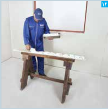
اجرای پرل‌فیکس بر پشت پنل نواری (برای پوشش کاری ناحیه داخلی دور بازشوی پنجره)
