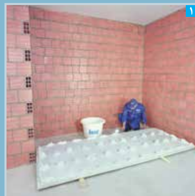
اجرای چانه های پرفلیکس بر پشت پنل مرکب PS
