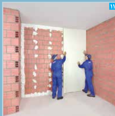
استقرار پنل بر روی دیوار زمینه
