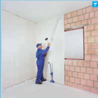
نصب و تنظیم پنل بر روی دیوار زمینه
