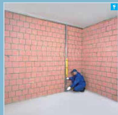
۴ انتقال تصویر رانر سقف به کف (با استفاده از استاد و تراز)
