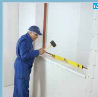
نصب و تنظیم سنگ کف پنجره
