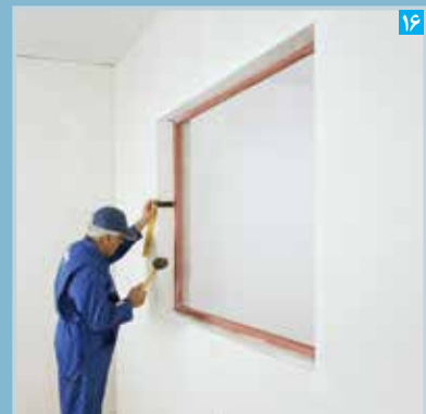
نصب و تنظیم پنل نواری
