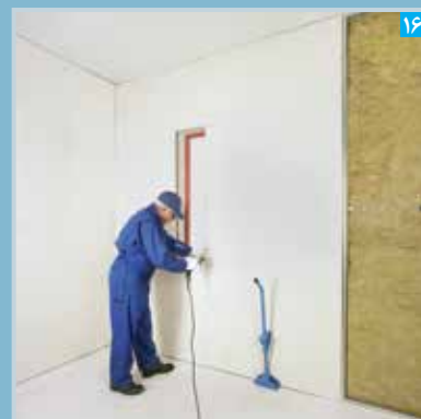
۱۶ نصب پنل بر روی زیرسازی
