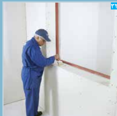
اجرای پرایمر بر روی سطح پتل
