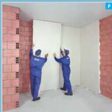
استقرار پنل بر روی دیوار زمینه
