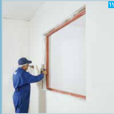
اجرای پرل‌فیکس بین پنل و دیوار بنایی (دور تا دور بازشوی پنجره)
