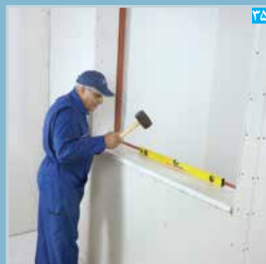
نصب و تنظیم سنگ کف پنجره
