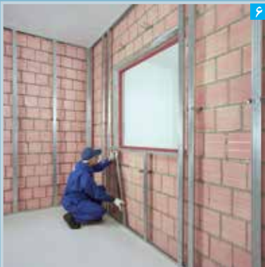
۶ استقرار سازه های قائم در سازه هادی کف، سازه قاب بندی تحتانی و براکت ها
