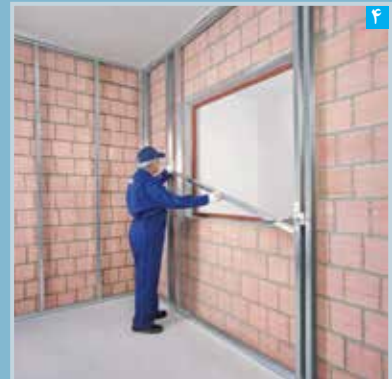
۴ استقرار رانر قاب بندی تحتانی (به جهت خم ها توجه شود)
