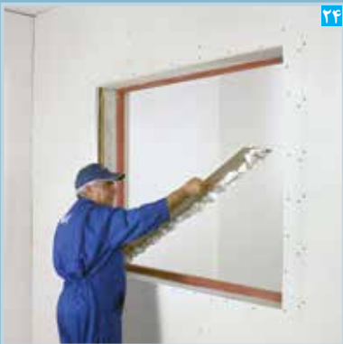
۲۴ استقرار پنل نواری در ناحیه داخلی دور بازشوی پنجره
