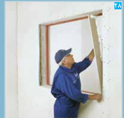
استقرار پتل نواری در ناحیه داخلی دور بازشوی پنجره (به اجرای یکپارچه پرفلیکس توجه شود)
