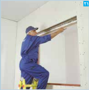
۲۱ استقرار پنل نواری در ناحیه داخلی دور بازشوی پنجره
