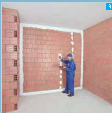
اجرای چانه های پرلنیکس بر روی دیوار زمینه (در فواصل مرکز به مرکز حداکثر ۳۵ س.م)
