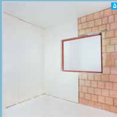
در محل بازشوی پنجره، برش پنل به صورت 'C' شکل صورت می گیرد
