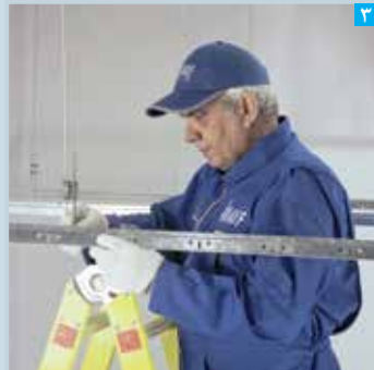
۳ اجرای سازه های اصلی T3600
