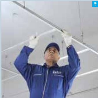
۴ اجرای سازه های فرعی T1200
