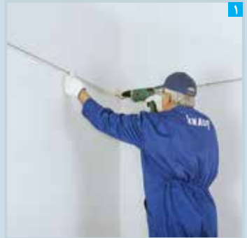
۱ نصب سازه تراز پس از تعیین خط تراز سقف
