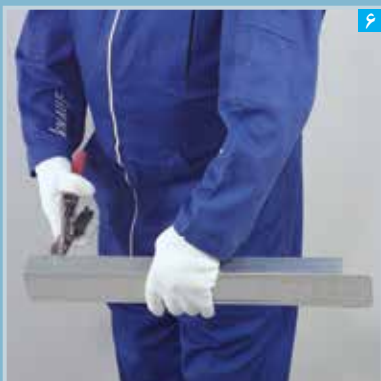
برش سازه پشت بند درز (به صورت زیانه)
