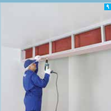
۹ اجرای پینل تحتانی
