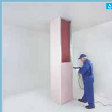
اجرای پنل‌های لایه اول
