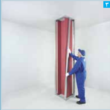
استقرار استادها در رانرهای کف و سقف
