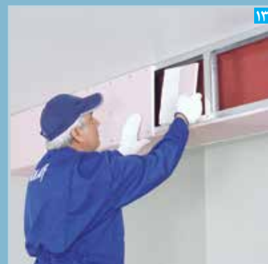
استقرار پنل پشت بند درز
