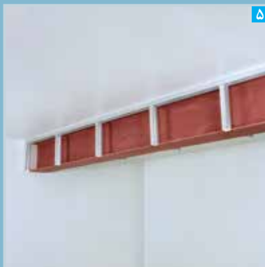
۵ سازه های فوقانی و قائم تکمیل شده
