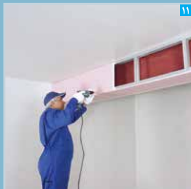
اجرای پنل جانبی
